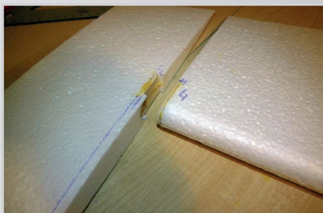
Slepení obou částí výškovky - již se zalepenými položebí
