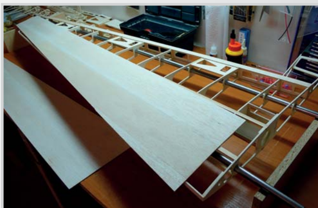
49. Připraven a obroušen potah náběžné části křídla
