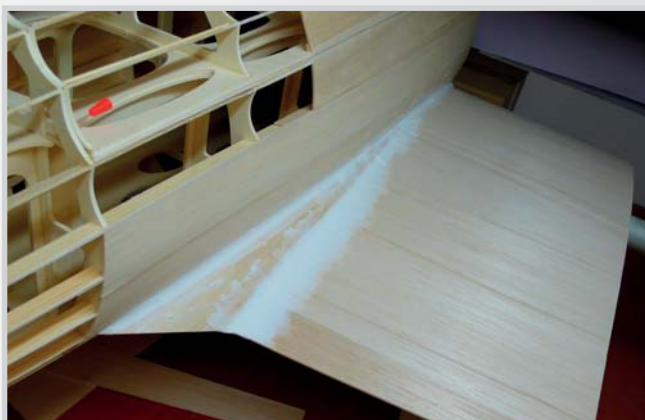
29. Přechod se dokončí tmelením
